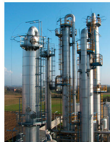
Рис. 8. Внешний вид ректификационной колонны
